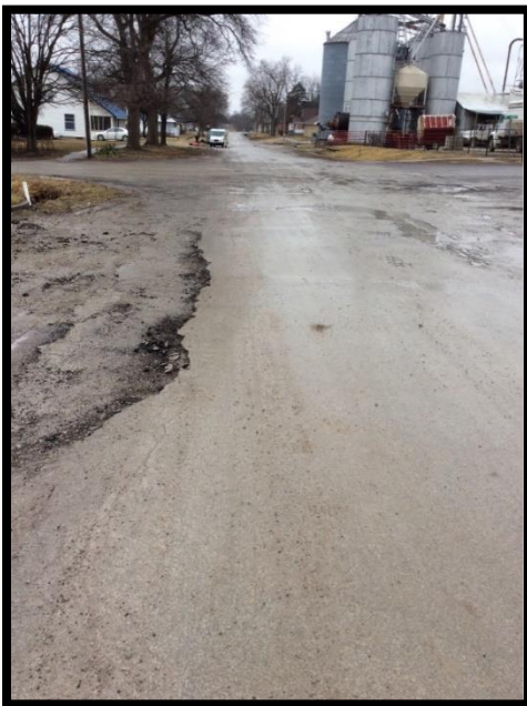
Edge Cracking
