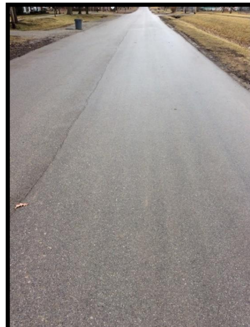
Longitudinal Cracking
